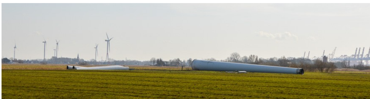
Abbau des Windparks in Schottwarden.
