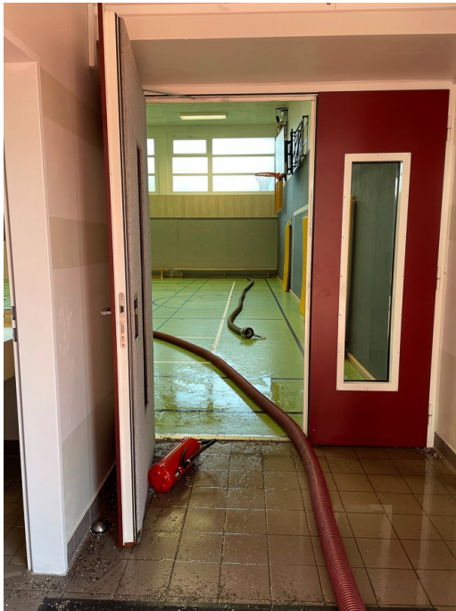
Wasser wird aus der Turnhalle abgepumpt.
