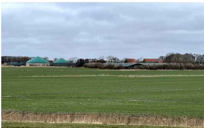
Die Biogasanlage mit den Ställen zur Hühneraufzucht am nördlichen Ende des Ortes.
