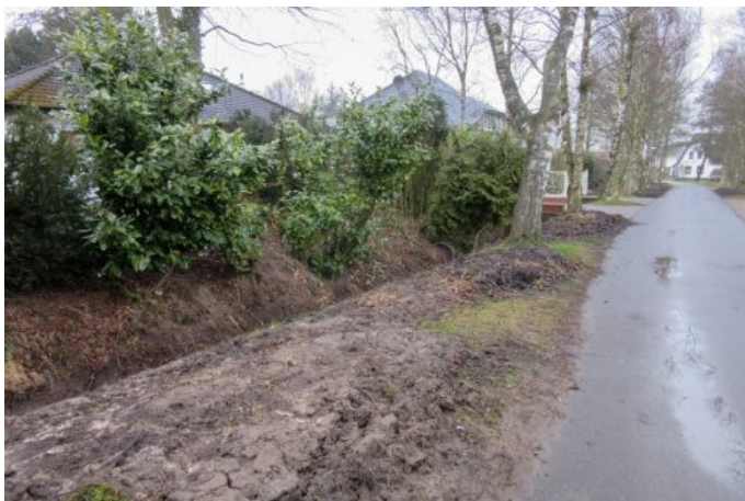
Zugegeben, der Neue Weg ist ein Schmuckstück, aber auch da müssen mal Gräben geräumt werden. Die letzte Räumung 2018 liegt schon etwas zurück.
