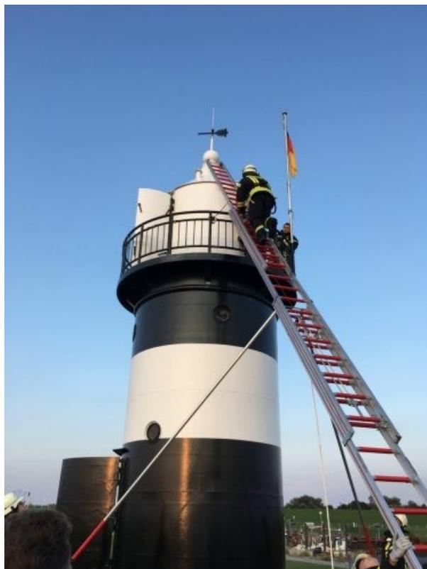
Die Lagerung des Windweisers hat seit 14 Jahren dem Wetter getrotzt, aber nun hatte Rost die Funktion sehr beeinträchtigt. Der einfache Aufbau mit Blech- und Plastikscheiben war schon mehrmals von Handwerkern des Heimatkreises geschmiert worden, nun hilft nur noch eine Neukonstruktion. Bis Mitte September wird der neue Windweiser auf sich warten lassen, die Feuerwehr hat zugesagt beim Aufbau wieder behilflich zu sein.
