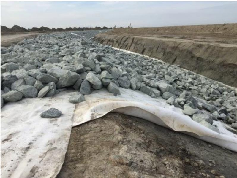
Vor Rintzeln befindet sich zur Zeit eine Großbaustelle, die erodierte Uferkante wird befestigt. Nach Scheitern des "sanften Küstenschutzes" wird jetzt eine Verwaltung aus Wasserbausteinen gebaut. Dahinter entsteht ein Asphaltweg, der Ausspülungen hinter dem Steinwall verhindert und dem Abtransport von Treibsel dient. Nach Süden bekommt der Wall Anschluss an den schon bestehenden Wall, der bis zur Wasserlöse reicht. Aber der Asphaltweg endet weiter nördlich in einem Wendehammer.
