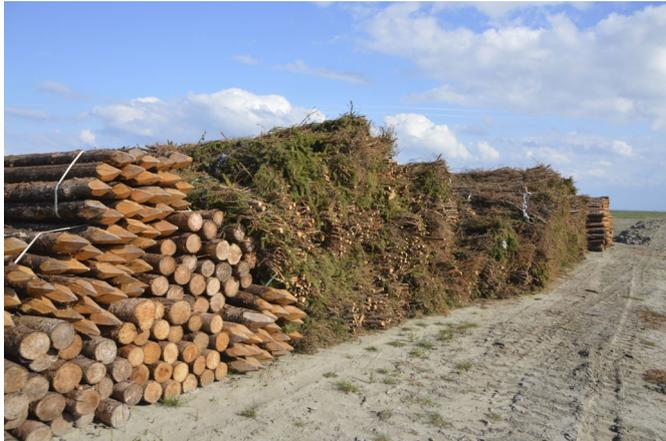
Am Deich vor Rintzeln liegen angespitzte Holzpflocke und Pakete aus Sträuchern für die Instandsetzung der **Lahnungsfelder**. Die Uferschutzanlagen bestehen aus doppelten Reihen Holzpflocken, die im Uferbereich in den Boden getrieben werden. Die dazwischen geschürten Sträucher verlangsamen die Strömung und begünstigen die Sedimentablagerung.
