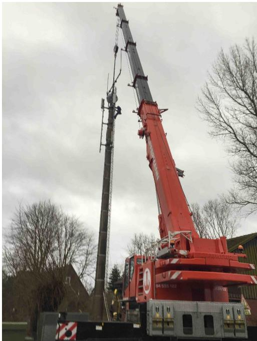
**Der Funkturm im Südersteinweg** wird im Februar abmontiert. Zwischen 1978 und 1982 wurde er von der Bundespost für den Telefonverkehr errichtet. Ein Kran nimmt ihn aus der Verankerung, dann wird er zerlegt und verschrottet. Seine Dienst hat er schon vor einigen Jahren eingestellt und ist durch den neuen Turm an der Bahn ersetzt worden.
