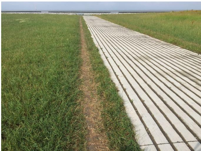
*Vor Schottwarden verhindert der Beton mit tiefen Riffeln das Befahren durch Radfahrer.*
