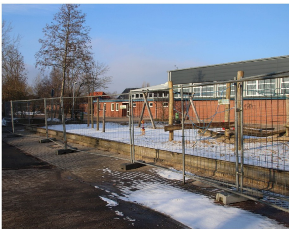
Der Zaun trennt den Schulhof von der Durchfahrtsstraße für Baufahrzeuge.
