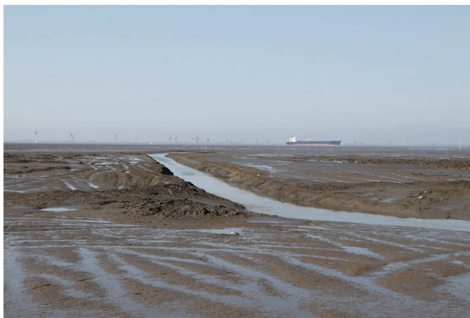
Nach der Verlegung verhindern zwei Buhnen das Wasser, in die alten Bahnen zurückzukehren. Der Aushub wird genutzt, um den bisherigen Wasserlauf zu verfüllen. Im weichen Schlick drohen Bagger und LKW zu versinken und das alte Bett kann nicht vollständig verfüllt werden.
