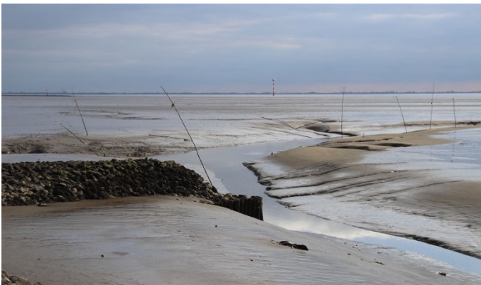
Die kurze Buhne am Kleinen Preußen wird von der Rhee unterspült.
