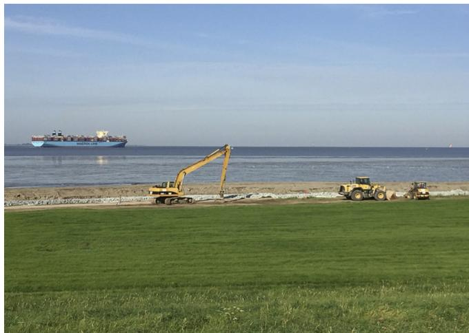
Eigentlich sollte die **Deichbaustelle** in dem Jahr fertig werden. Die Granitsteine werden noch durch Spezialbeton verklammert, aber der Asphaltweg hinter der Steinmauer wird erst im nächsten Jahr angelegt. Auch die Lahnungsfelder vor der Küste werden erst nächstes Jahr gebaut, dort sollen sich Salzwiesen als Ausgleich für den Deckwerkbau entwickeln.
