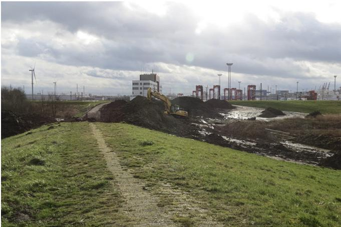
*Ein Deich wird abgebaut, die Kleierde kommt auf eine Deponie für spätere Deichbauarbeiten.*
