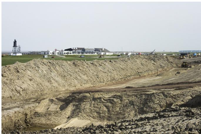
*Eine riesige Lücke ist im Deich entstanden, die mit Sand gefüllt wird. Anschließend wird Kleiboden und anschließend Grassaat aufgebracht.*
