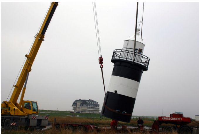
Mit Hilfe eines Krans wird der Turm angehoben.
