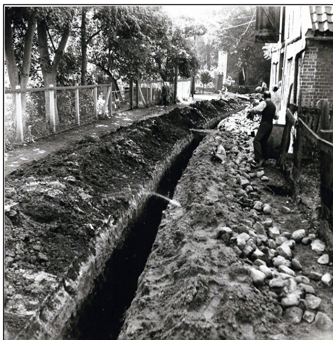
Verlegung der Wasserleitung in der Langen Straße
