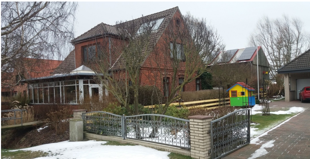
Vorderansicht nach Anbau des Wintergartens 2021
