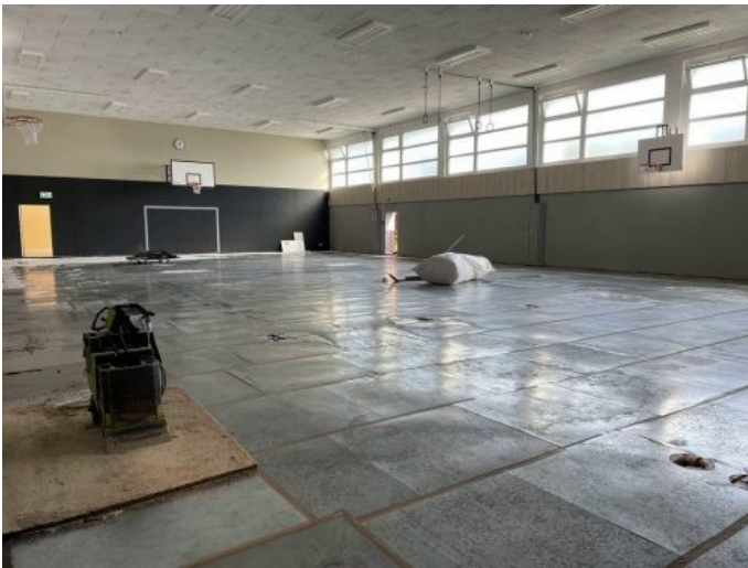
Rechts: klitschnasses Dämmmaterial aus der Schulturnhalle
