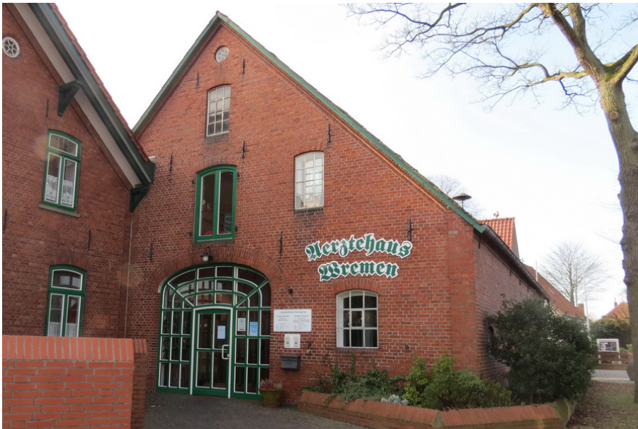
Früher Scheune – jetzt Praxisgebäude
